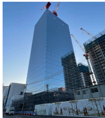
建設中の施設
